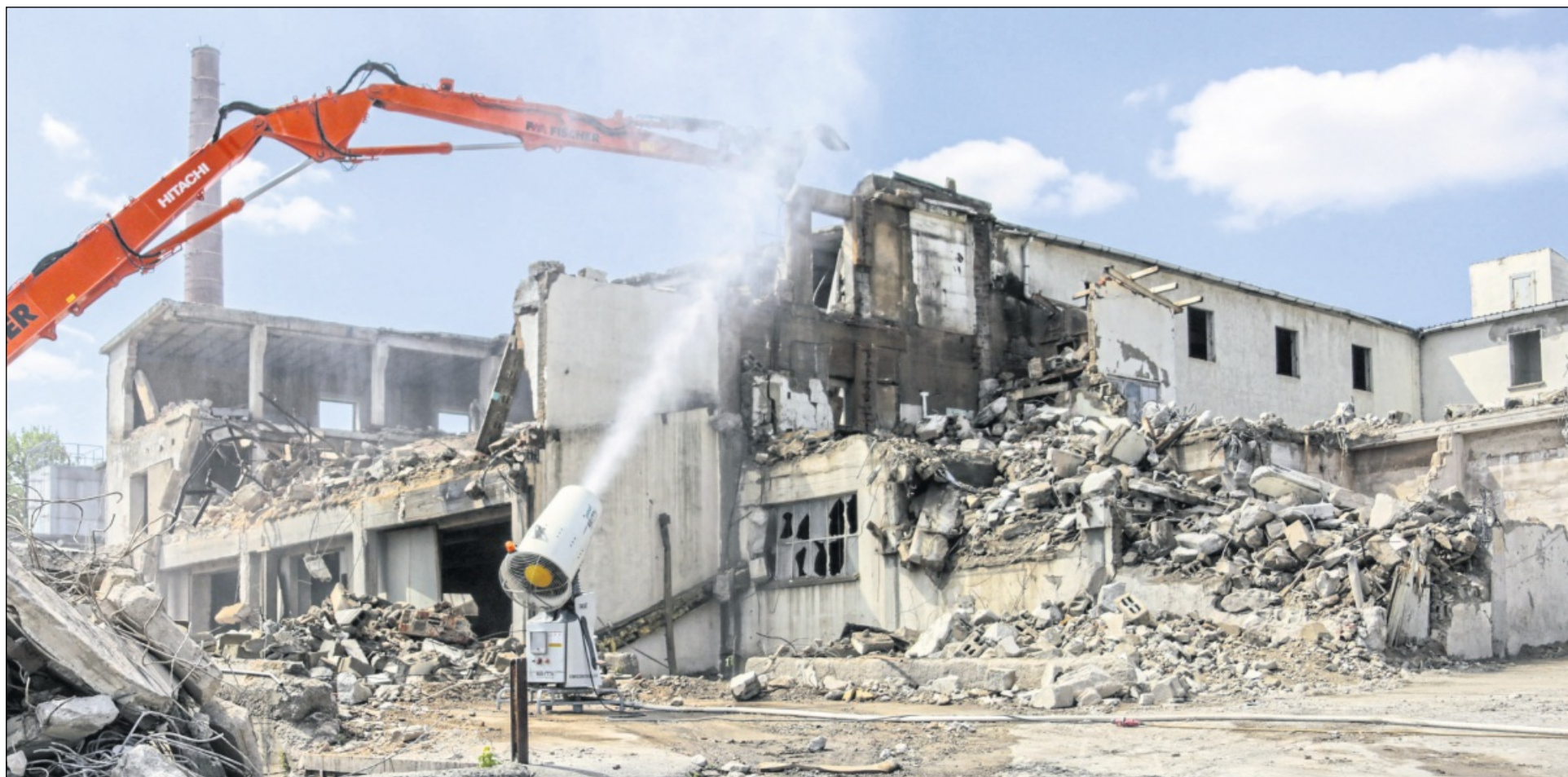
MITHILFE EINER SCHNEEKANONE gehen die Abbrucharbeiten auf dem ehemaligen Steinzeugwerk-Gelände im Brettener Norden vorstatten: Die abgefeuerte Flüssigkeit sorgt dafür, dass der Staub auf dem Gelände bleibt und nicht in die Nachbarschaft geweht wird. Das Thema Neubau steht am Dienstag auf der Agenda des Gemeinderats. Fotos (2): Rebel
